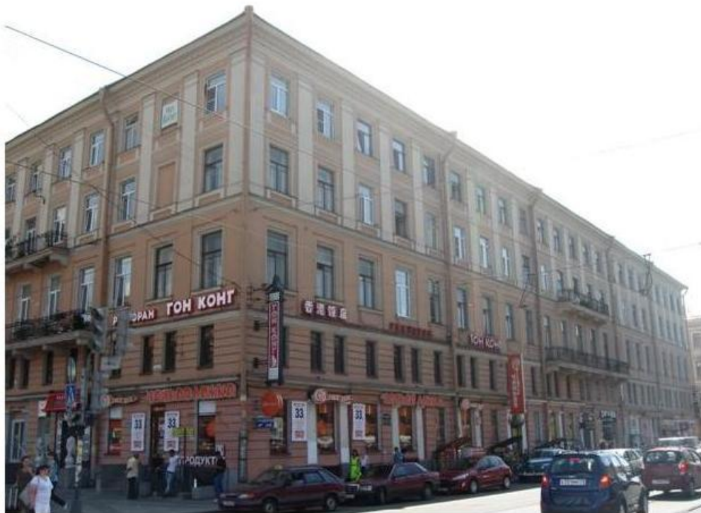
Рис. 8. Дом 42 по Садовой улице. Вид с противоположной стороны Садовой улицы. Фото автора.
